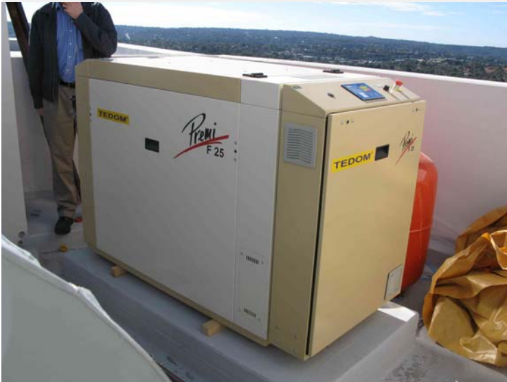
Tedom F25AP Cogen unit
